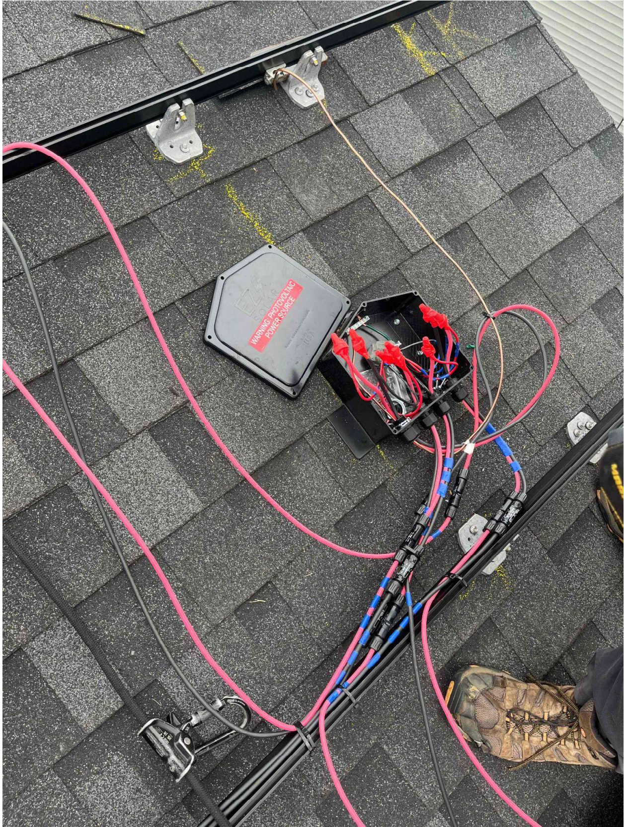
Inspection Photos: 213 Windswept Wy, Fuquay-Varina, NC 27526 (Szabo)
