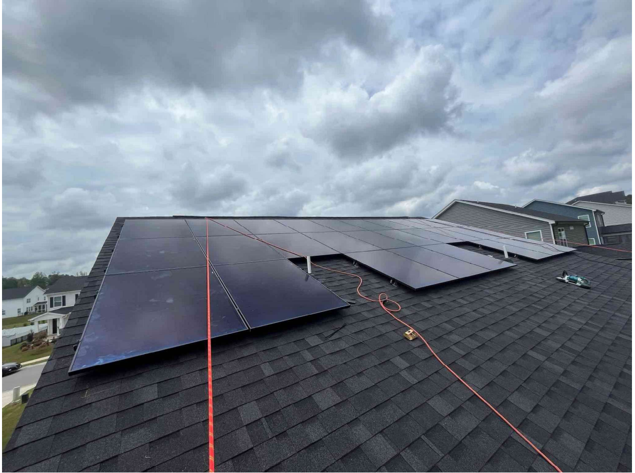
Inspection Photos: 213 Windswept Wy, Fuquay-Varina, NC 27526 (Szabo)
