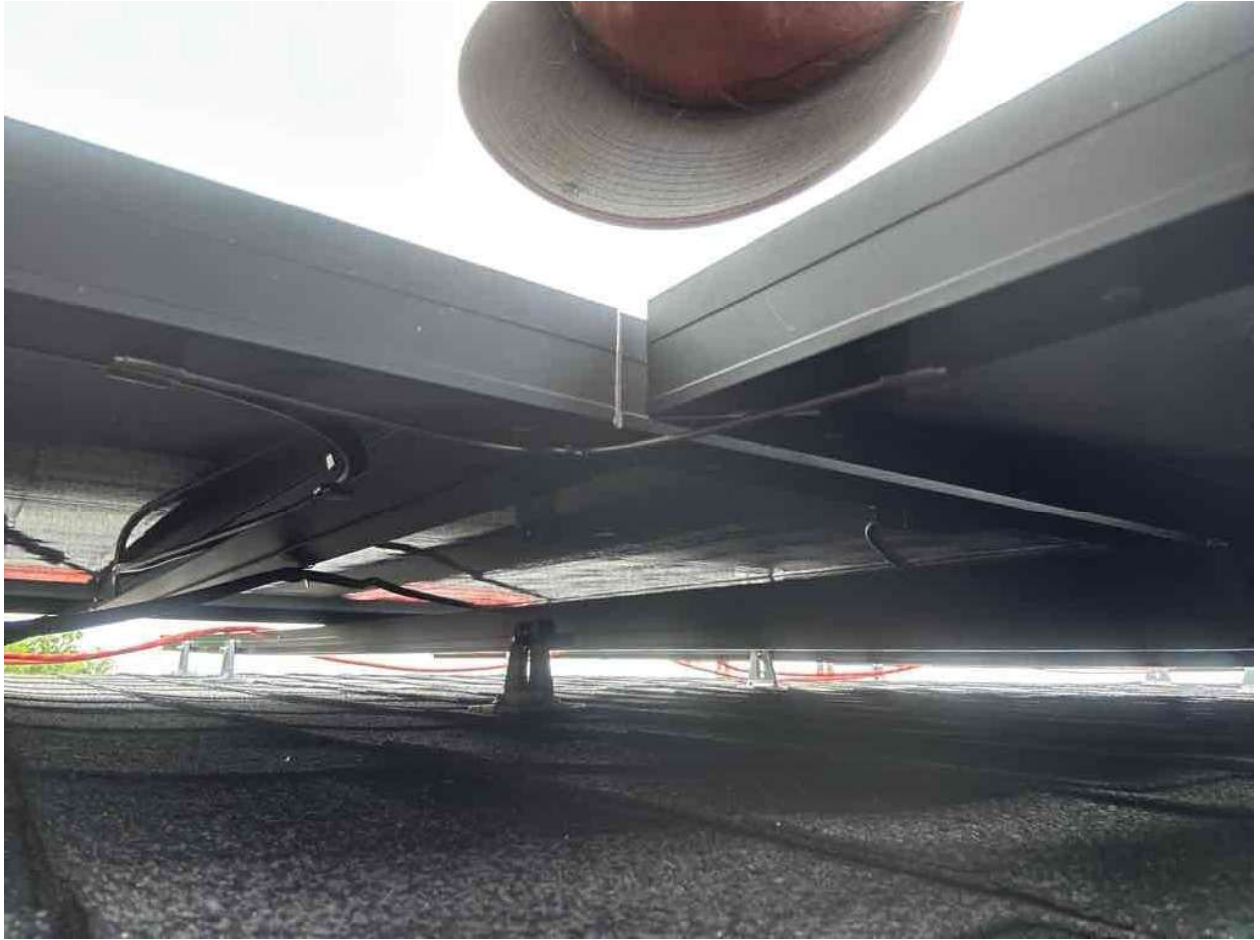
Inspection Photos: 213 Windswept Wy, Fuquay-Varina, NC 27526 (Szabo)
