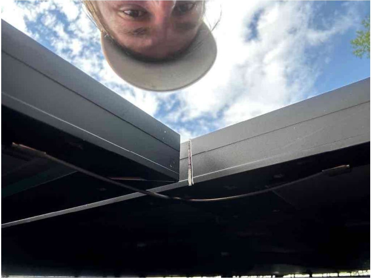
Inspection Photos: 213 Windswept Wy, Fuquay-Varina, NC 27526 (Szabo)
