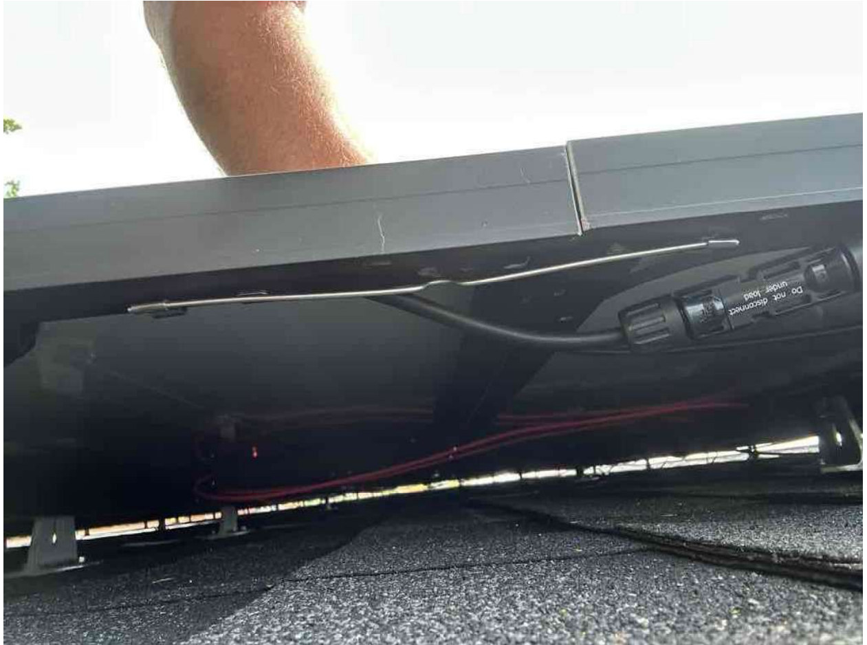
Inspection Photos: 213 Windswept Wy, Fuquay-Varina, NC 27526 (Szabo)
