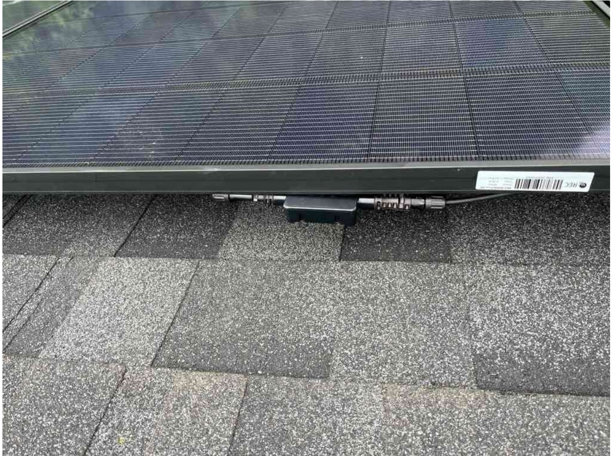
Inspection Photos: 213 Windswept Wy, Fuquay-Varina, NC 27526 (Szabo)
