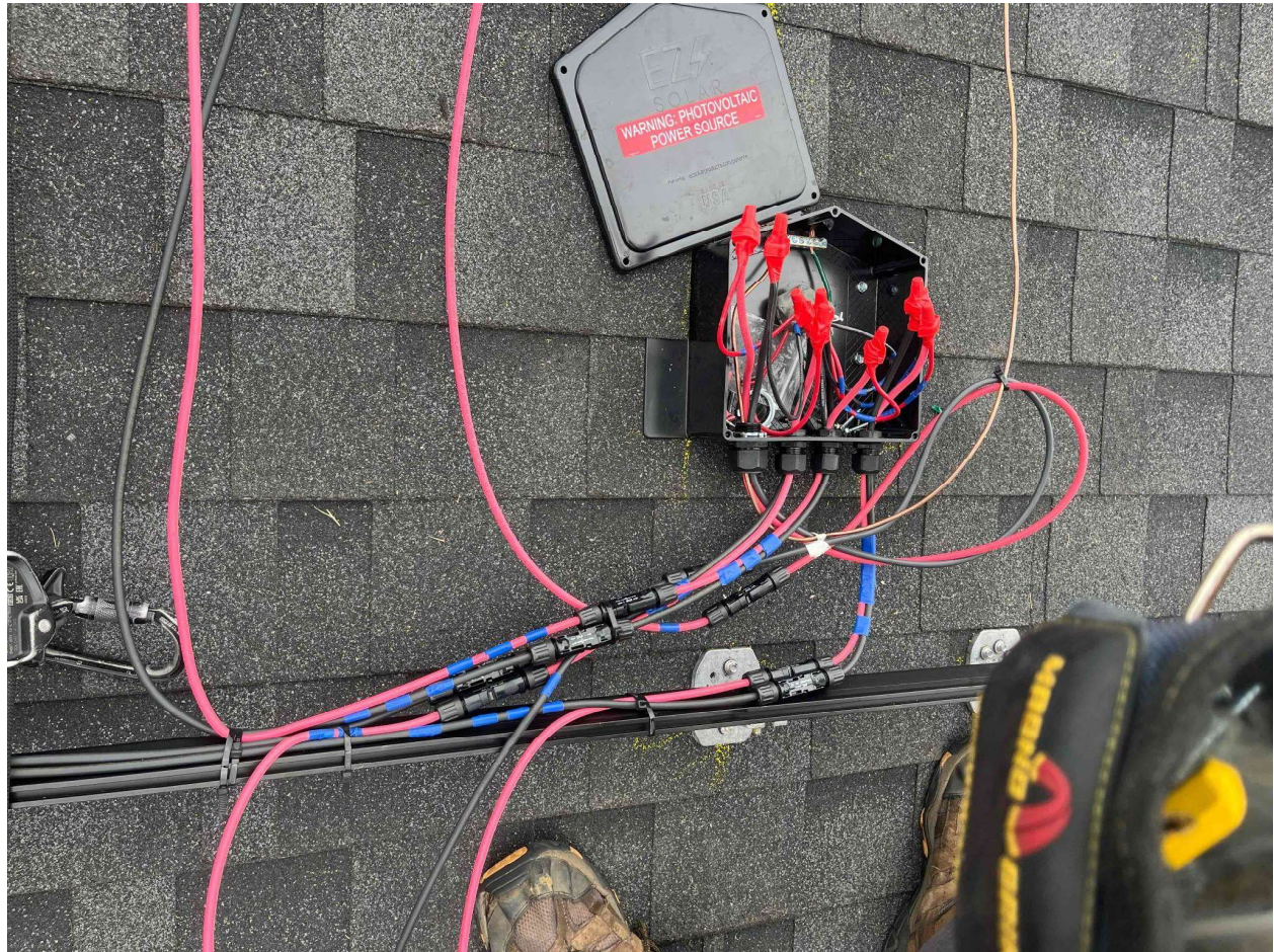
Inspection Photos: 213 Windswept Wy, Fuquay-Varina, NC 27526 (Szabo)
