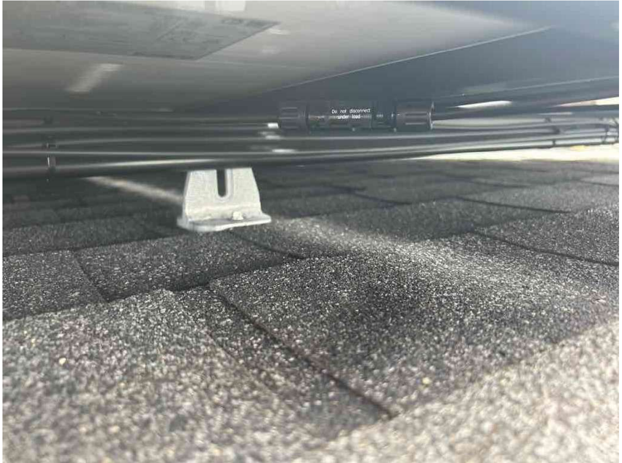
Inspection Photos: 213 Windswept Wy, Fuquay-Varina, NC 27526 (Szabo)
