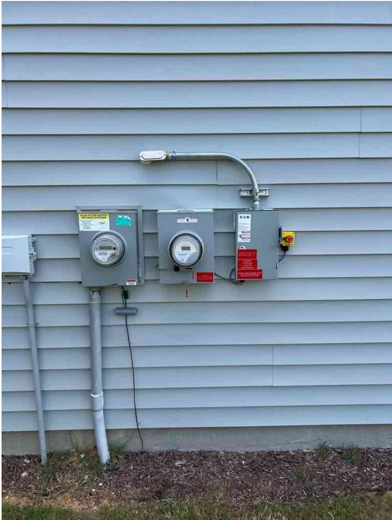
Inspection Photos: 213 Windswept Wy, Fuquay-Varina, NC 27526 (Szabo)
