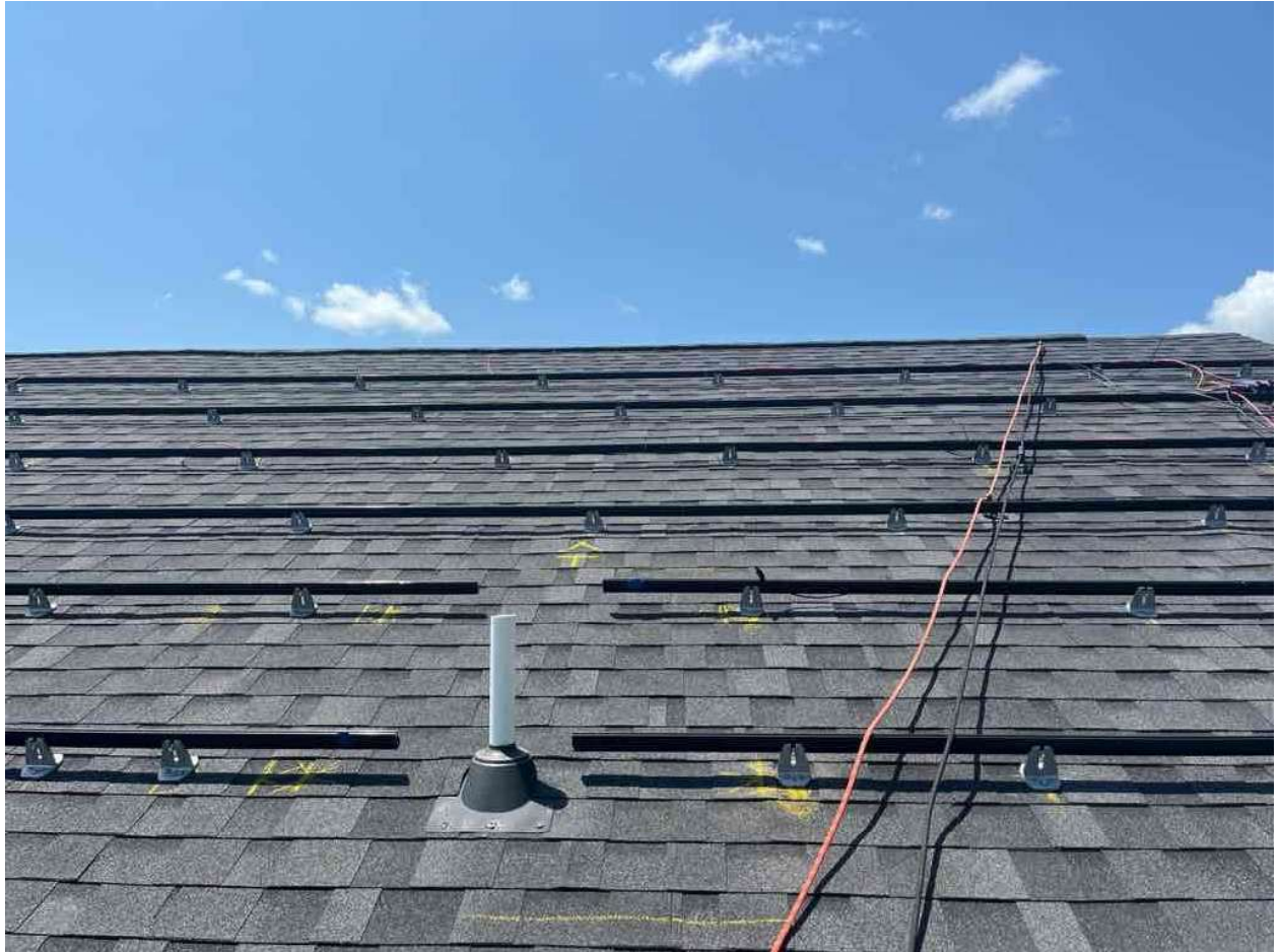
Inspection Photos: 213 Windswept Wy, Fuquay-Varina, NC 27526 (Szabo)
