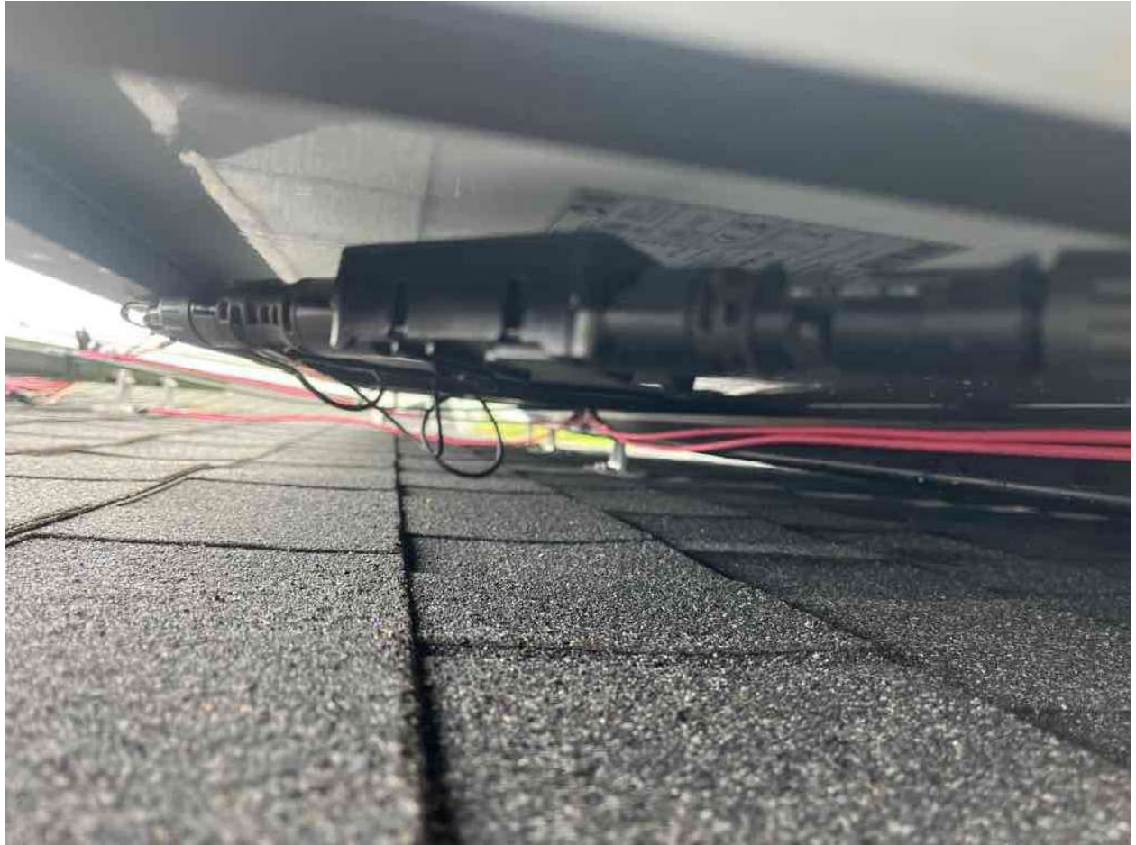
Inspection Photos: 213 Windswept Wy, Fuquay-Varina, NC 27526 (Szabo)
