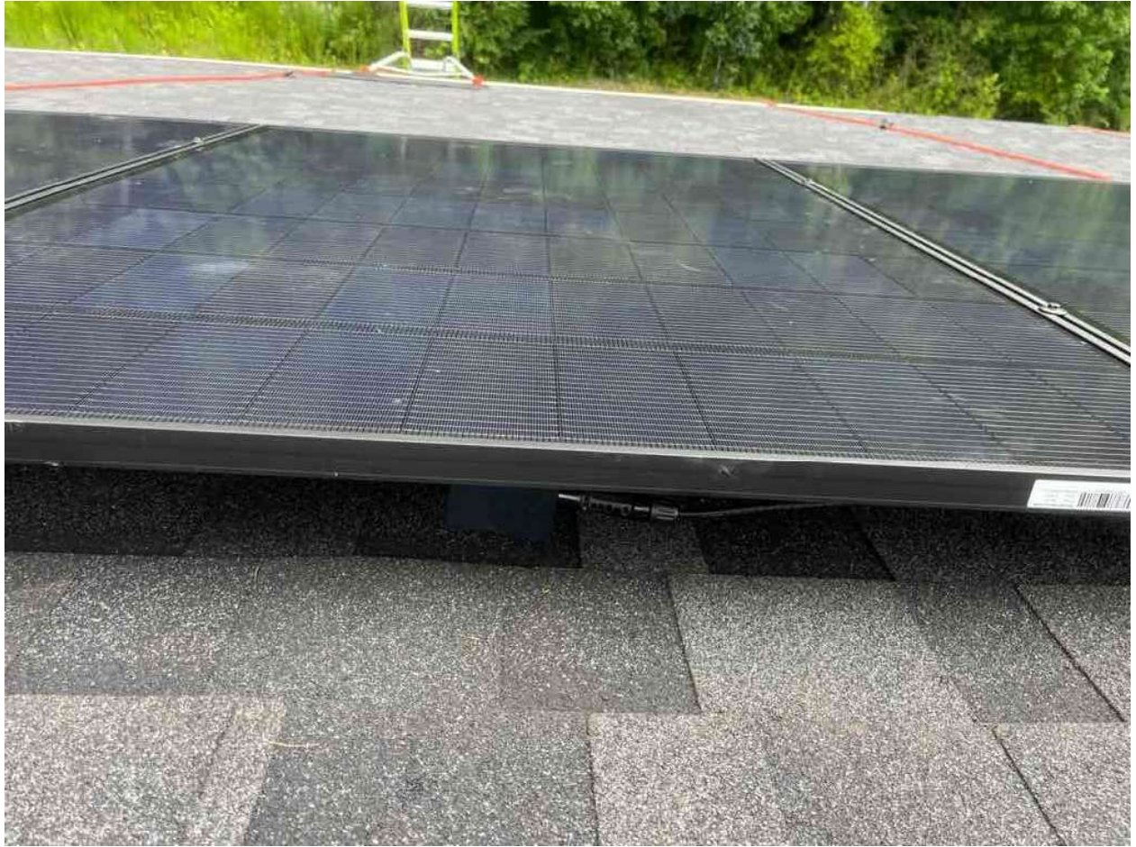
Inspection Photos: 213 Windswept Wy, Fuquay-Varina, NC 27526 (Szabo)
