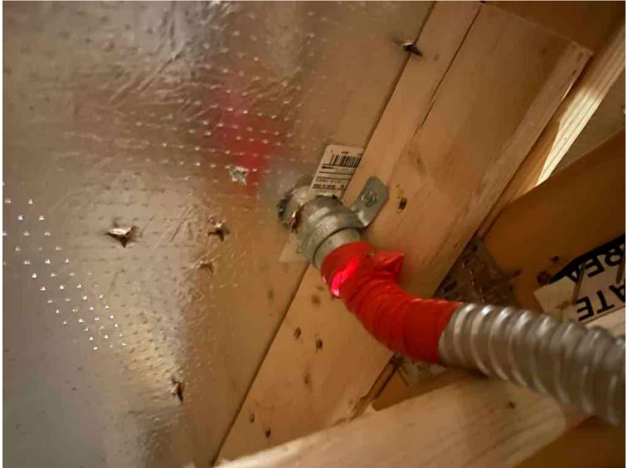
Inspection Photos: 213 Windswept Wy, Fuquay-Varina, NC 27526 (Szabo)
