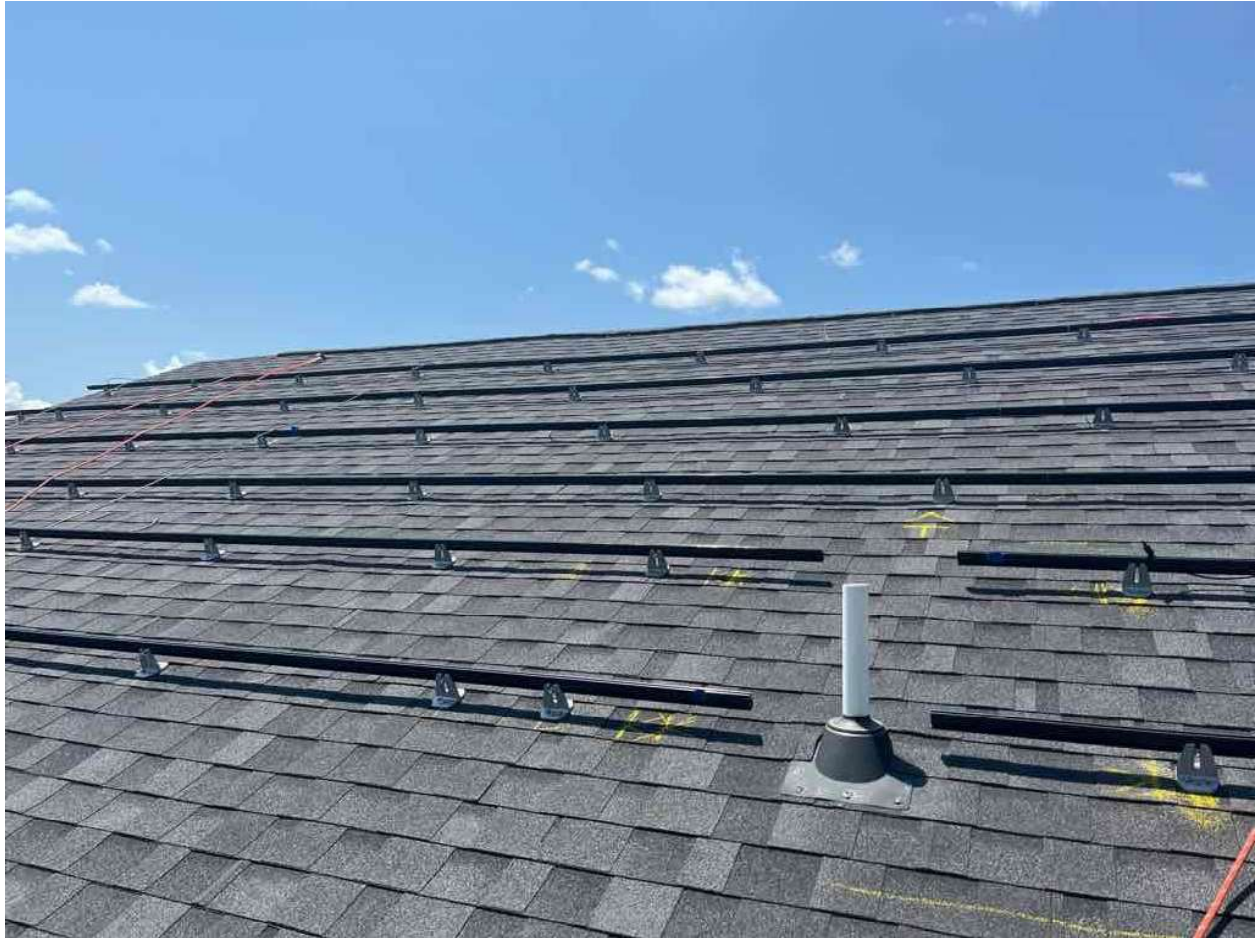
Inspection Photos: 213 Windswept Wy, Fuquay-Varina, NC 27526 (Szabo)
