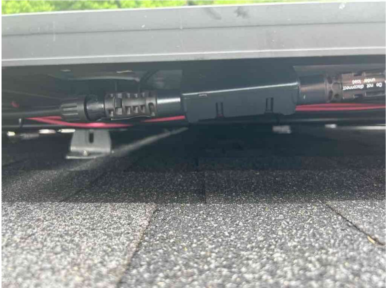
Inspection Photos: 213 Windswept Wy, Fuquay-Varina, NC 27526 (Szabo)
