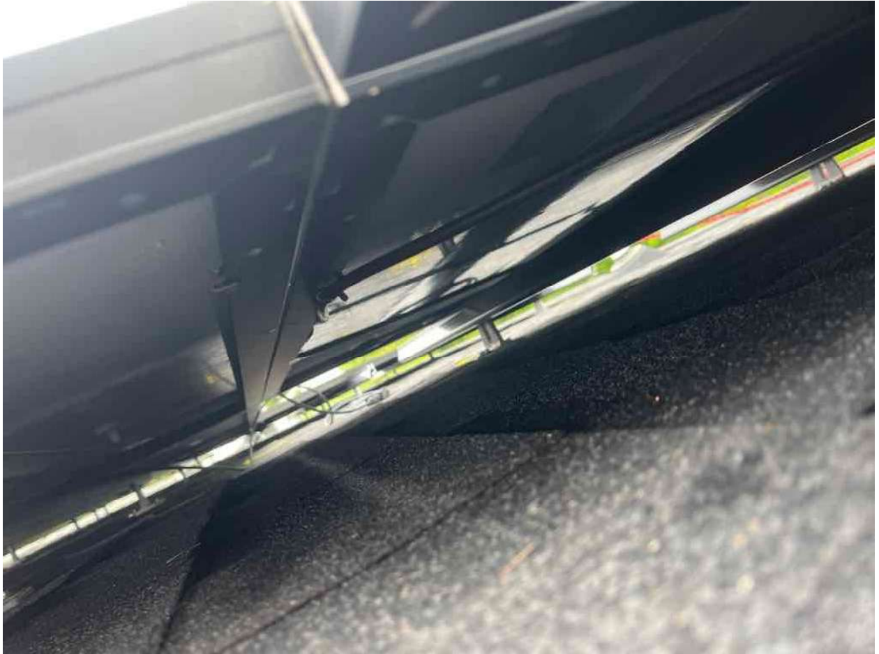
Inspection Photos: 213 Windswept Wy, Fuquay-Varina, NC 27526 (Szabo)
