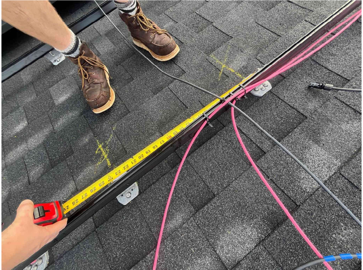
Inspection Photos: 213 Windswept Wy, Fuquay-Varina, NC 27526 (Szabo)
