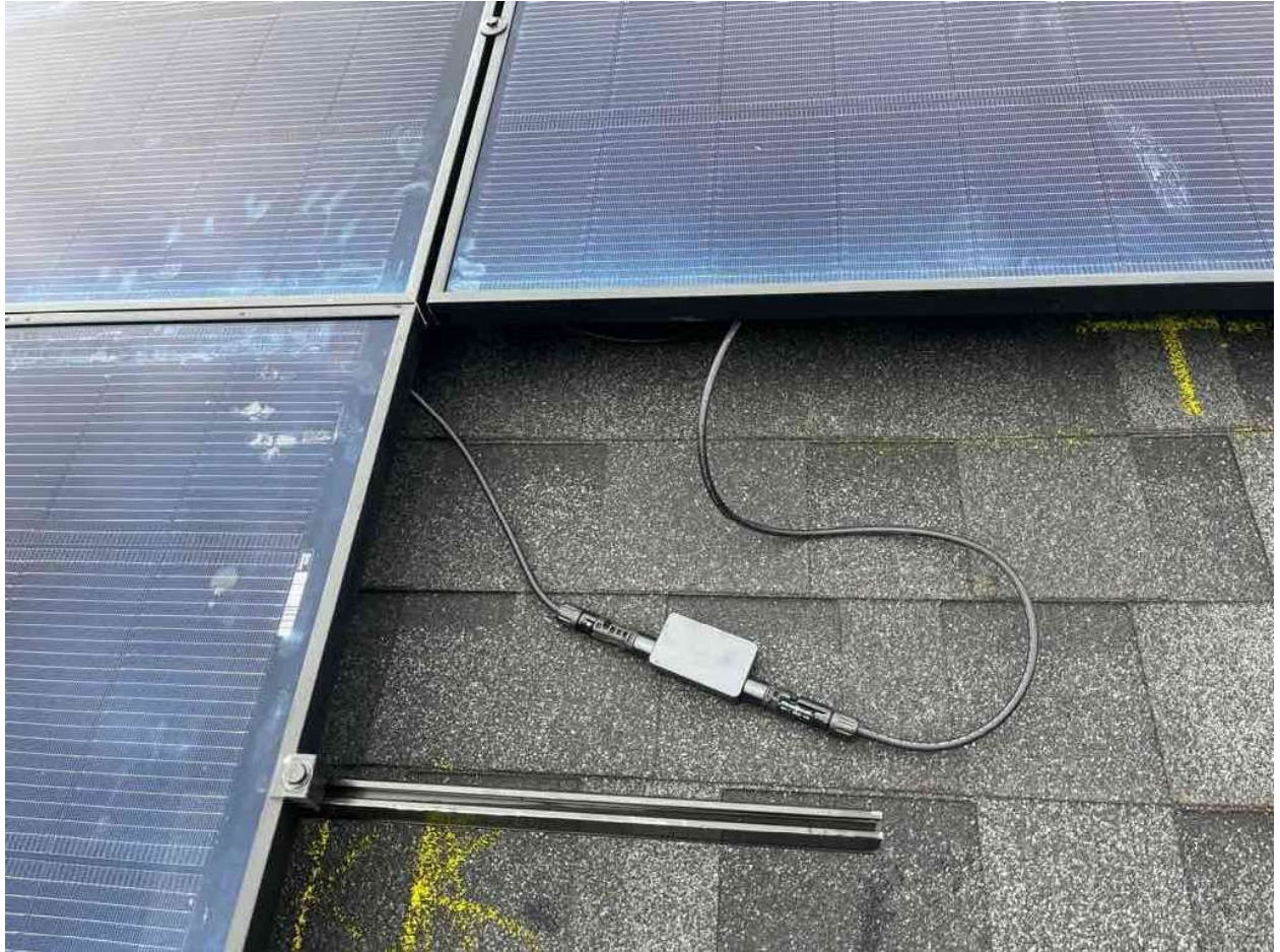
Inspection Photos: 213 Windswept Wy, Fuquay-Varina, NC 27526 (Szabo)
