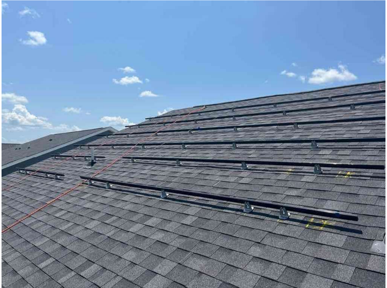
Inspection Photos: 213 Windswept Wy, Fuquay-Varina, NC 27526 (Szabo)
