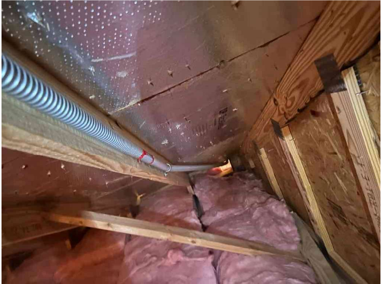
Inspection Photos: 213 Windswept Wy, Fuquay-Varina, NC 27526 (Szabo)
