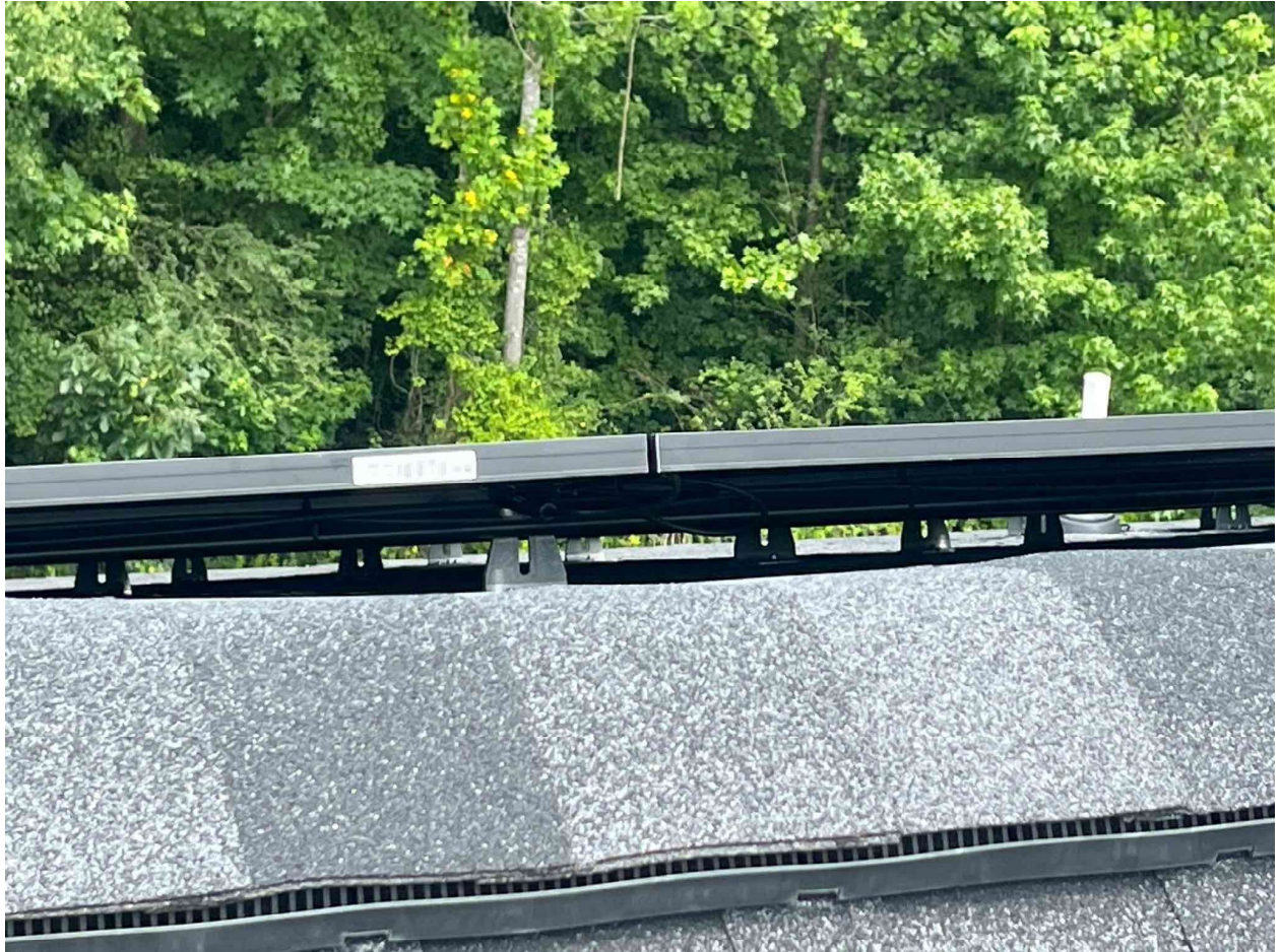
Inspection Photos: 213 Windswept Wy, Fuquay-Varina, NC 27526 (Szabo)
