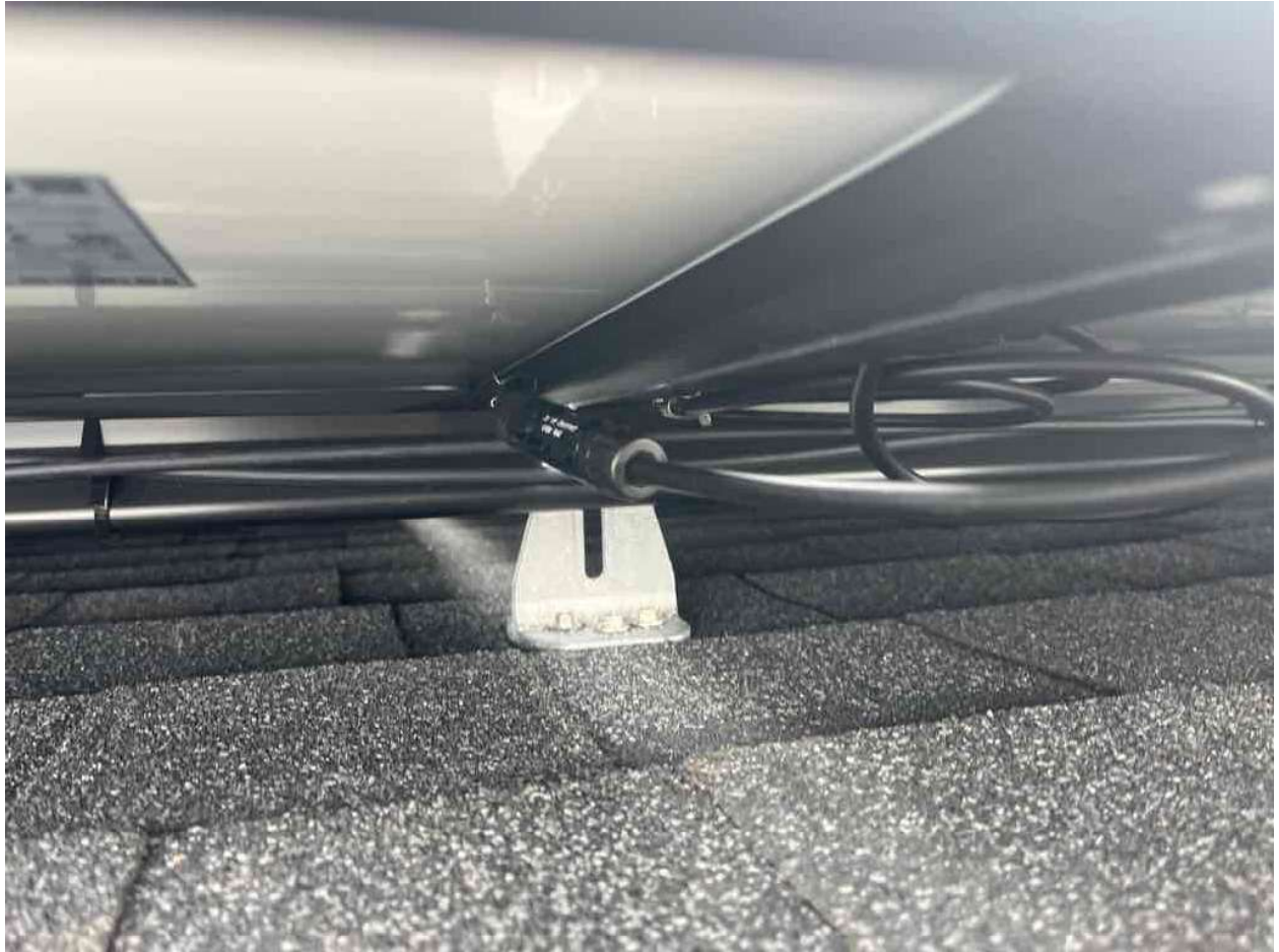
Inspection Photos: 213 Windswept Wy, Fuquay-Varina, NC 27526 (Szabo)
