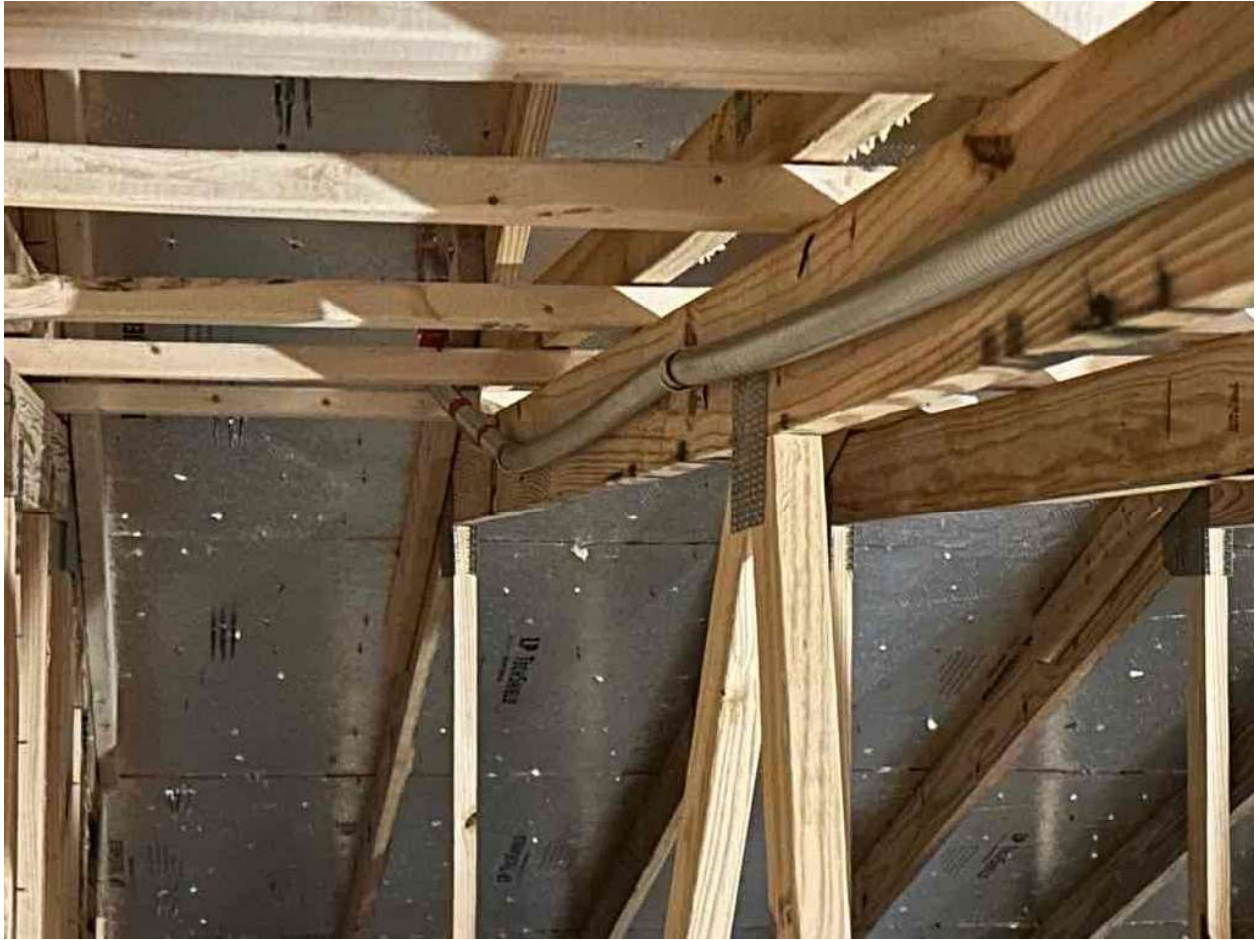
Inspection Photos: 213 Windswept Wy, Fuquay-Varina, NC 27526 (Szabo)
