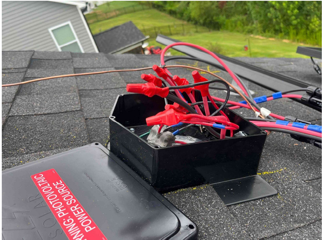
Inspection Photos: 213 Windswept Wy, Fuquay-Varina, NC 27526 (Szabo)
