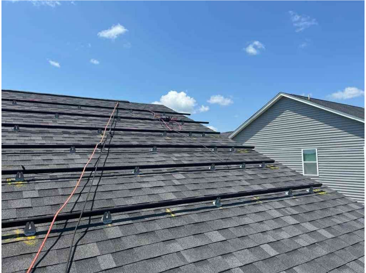
Inspection Photos: 213 Windswept Wy, Fuquay-Varina, NC 27526 (Szabo)
