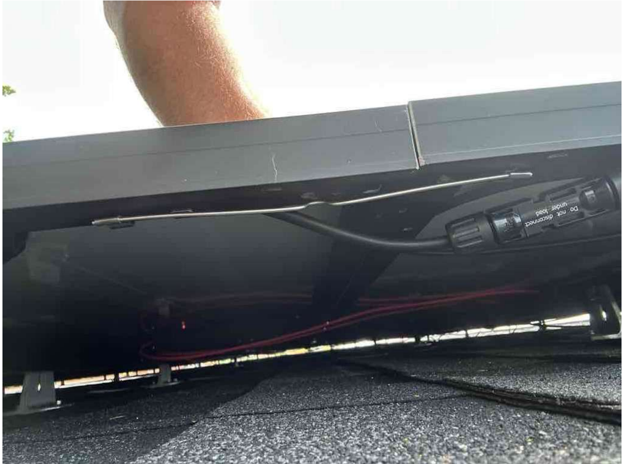
Inspection Photos: 213 Windswept Wy, Fuquay-Varina, NC 27526 (Szabo)
