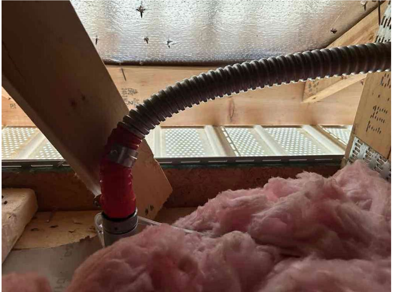
Inspection Photos: 213 Windswept Wy, Fuquay-Varina, NC 27526 (Szabo)
