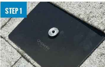
INSTALL FLASHKIT PRO FLASHING
