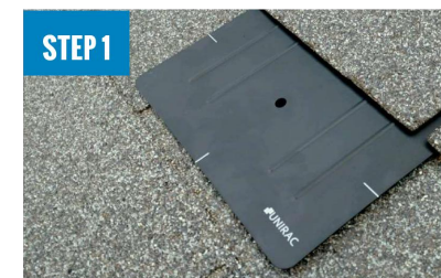
INSTALL FLASHKIT PRO FLASHING
