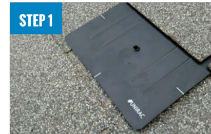
INSTALL FLASHKIT PRO FLASHING
