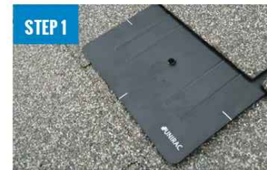
INSTALL FLASHKIT PRO FLASHING
