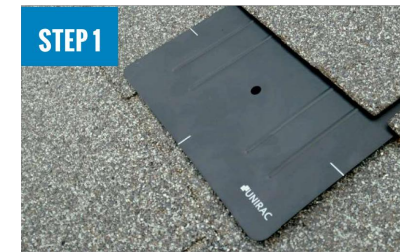
INSTALL FLASHKIT PRO FLASHING
