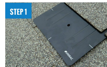
INSTALL FLASHKIT PRO FLASHING
