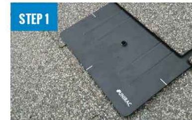
INSTALL FLASHKIT PRO FLASHING
