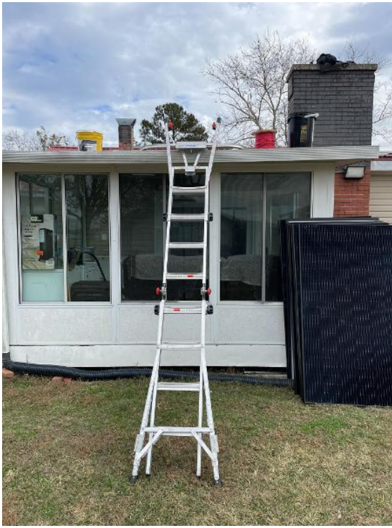
Crew & Safety / Instaladores y Seguridad / Proper Ladder Setup
