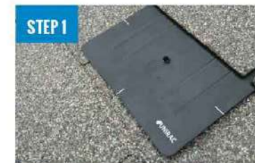
INSTALL FLASHKIT PRO FLASHING
