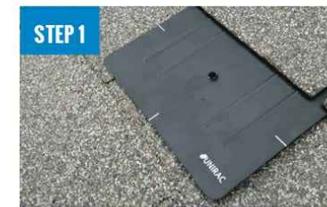
INSTALL FLASHKIT PRO FLASHING
