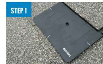
INSTALL FLASHKIT PRO FLASHING
