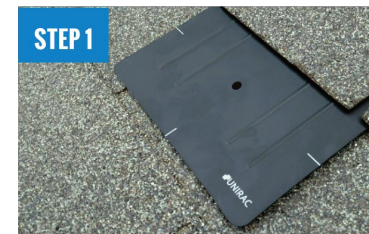
INSTALL FLASHKIT PRO FLASHING
