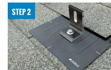
STEP 2 INSTALL L-FOOT
