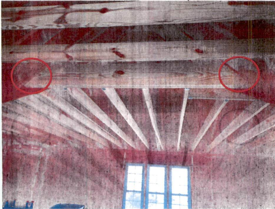
Item 4) Install (2) 2 x 6 Header Per Plan
