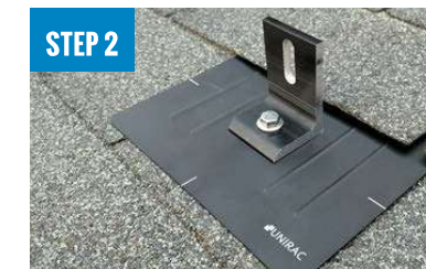
STEP 2 INSTALL L-FOOT
