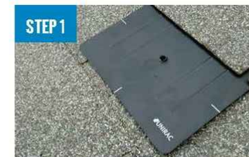
INSTALL FLASHKIT PRO FLASHING
