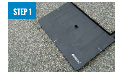
INSTALL FLASHKIT PRO FLASHING
