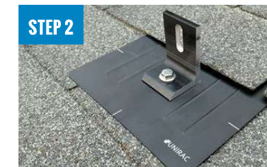
STEP 2 INSTALL L-FOOT
