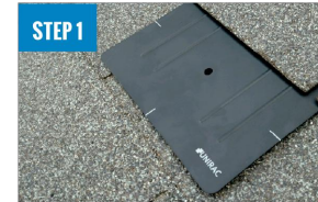
INSTALL FLASHKIT PRO FLASHING
