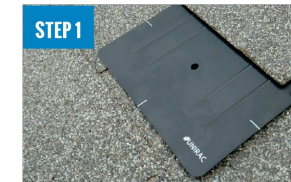
INSTALL FLASHKIT PRO FLASHING
