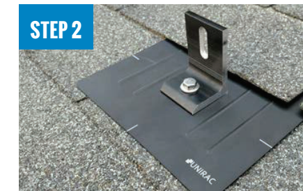
STEP 2 INSTALL L-FOOT
