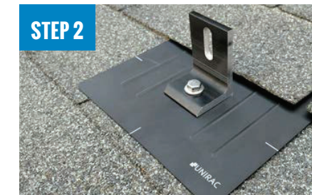
STEP 2 INSTALL L-FOOT
