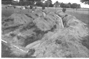
ou Griffis Repair HWY 210 5-
