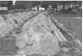
ou Griffis Repair HWY 210 5-9
