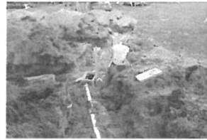
ou Griffis Repair HWY 210 5-
