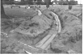
ou Griffis Repair HWY 210 5-
