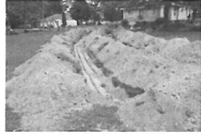
ou Griffis Repair HWY 210 5-
