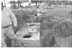
ou Griffis Repair HWY 210 5-
