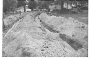
ou Griffis Repair HWY 210 5-
