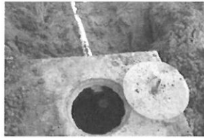
ou Griffis Repair HWY 210 5-
