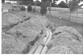
ou Griffis Repair HWY 210 5-
