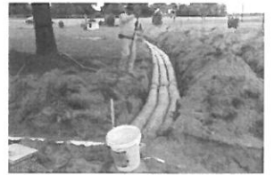
ou Griffis Repair HWY 210 5-
