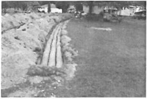
ou Griffis Repair HWY 210 5-9
