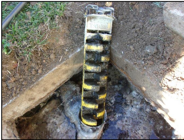
Soiled Effluent Strainer:
