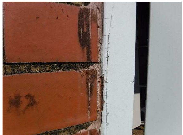
Photo #30 Non-asbestos Brown Door Caulk (HA #33)
